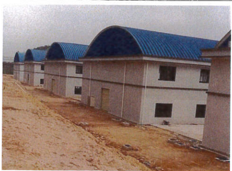
项目东南面-工厂
